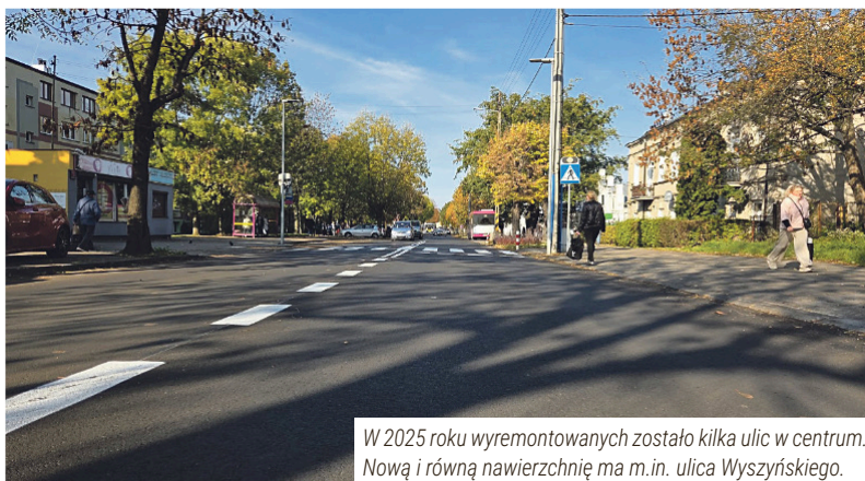
Przebudowana została ulica Kosmonautów. Oprócz jezdni z kostki brukowej, mieszkańcy zyskali także nowe chodniki.
