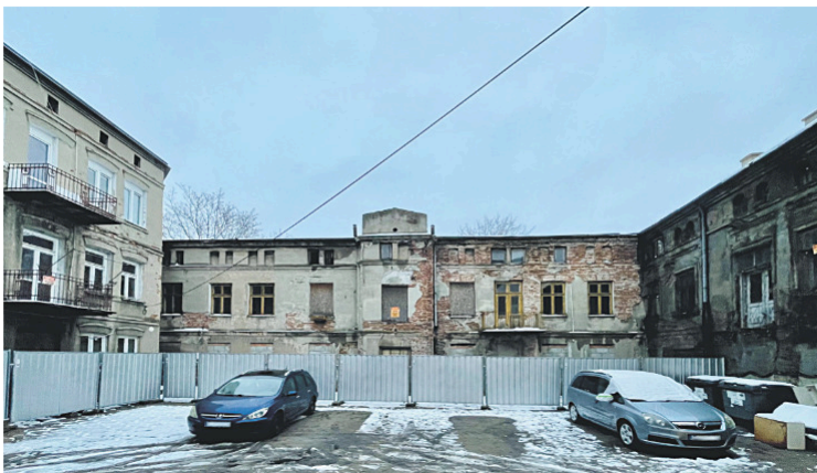
Przeznaczone do rozbiórki oficyny od lat stanowią zagrożenie budowlane.
