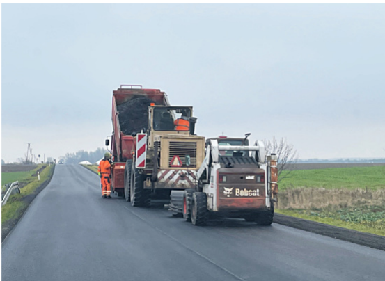
Droga wojewódzka nr 581 w gm. Łanietą w trakcie utwardzania poboczy.
