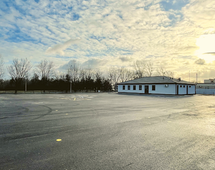
Obiekty WORD powstały na terenie po dawnej kotłowni szpitala. Obszar inwestycji oczyszczono, usunęto gruz i nagromadzone odpady roślinne. W tym miejscu powstał pokryty asfaltem plac manewrowy, na którym będą odbywały się egzaminy praktyczne.
